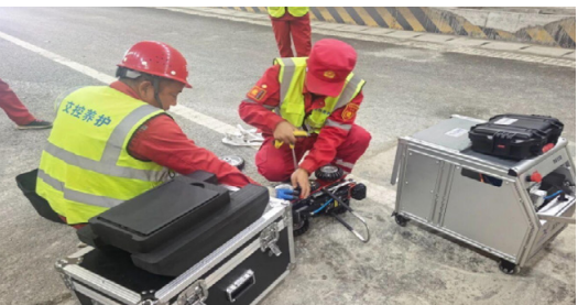
管道 CCTV 检测机器人青海久治隧道试点
