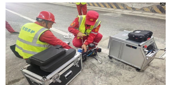
パイプ CCTV 検査ロボットによる青海久治トンネル実証試験
